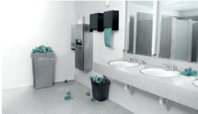
Les serviettes en papier peuvent rendre les toilettes malsaines et bon nombre d'entre elles se retrouvent avec un distributeur de serviettes vides.
