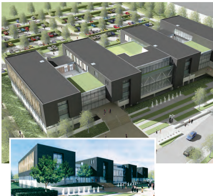
Pour la commune d'Herent, un nouveau centre administratif a été construit selon la formule DBFM.
