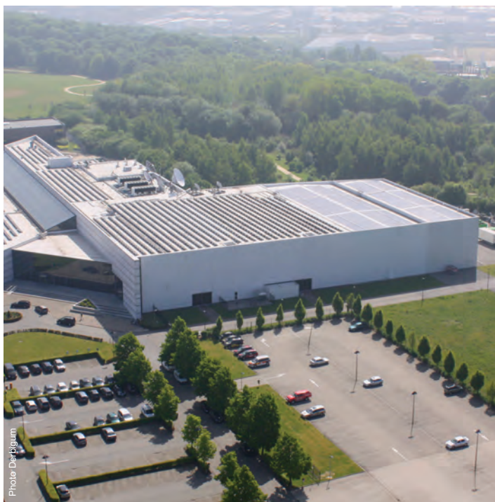
La toiture du bâtiment de VTM (Vlaamse Media Maatschappij) à Vilvoorde a été notamment équipée de 2.050 m 2 de panneaux souples Derbisolar
